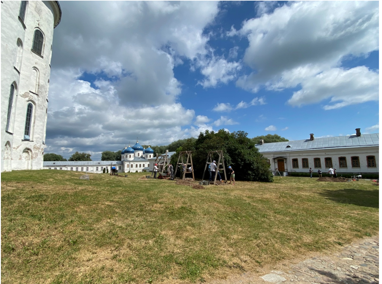
Переборка слоя строительного развала на «грохотах»
